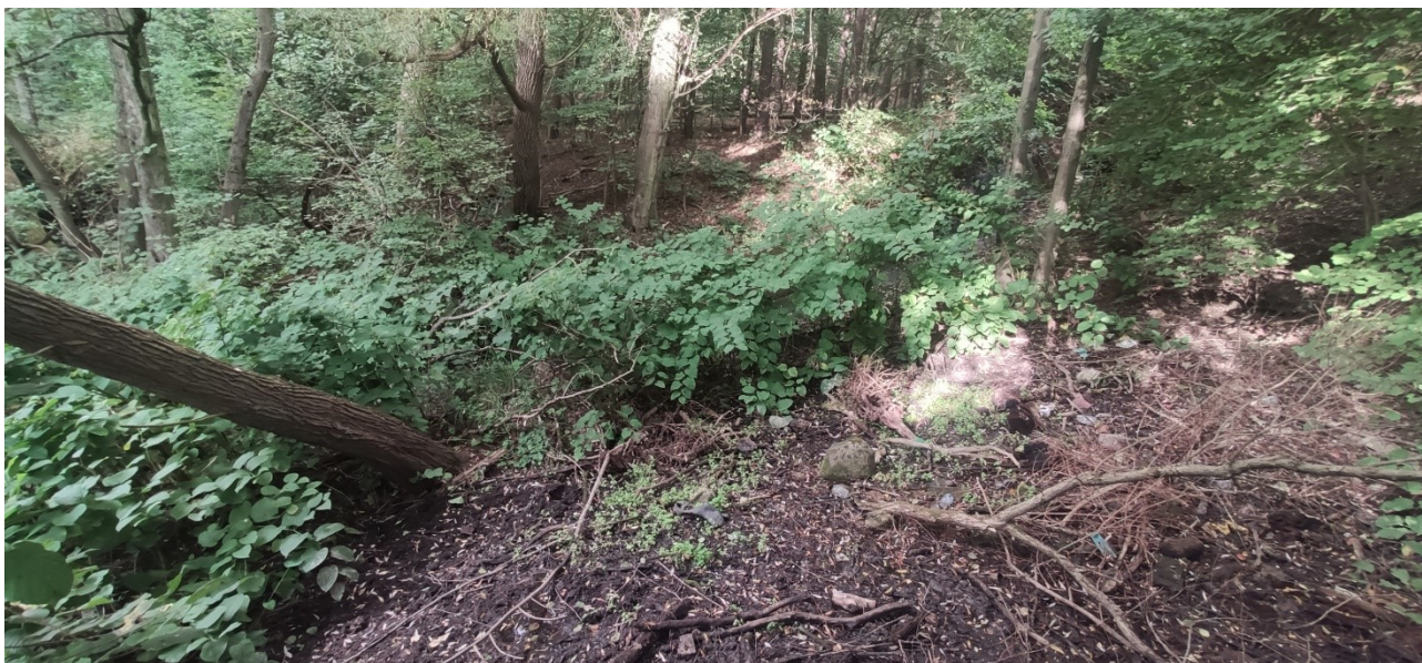
Fot. 1. Całkowicie zniszczone stare umocnienia skarpy na jęzorze osuwiska, zaciśnięcie koryta przez materiał koluwalny.
