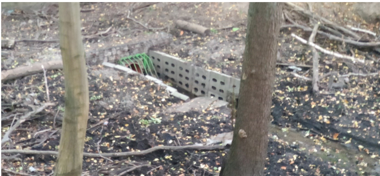
Fot. 4. Widok przepustu u podstawy osuwiska..
