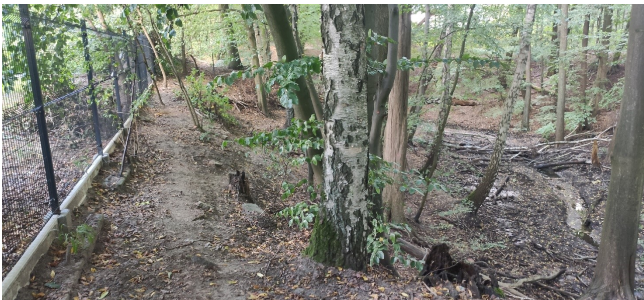
Fot. 3. Górna krawędź osuwiska dochodząca do ogrodzenia. Brak zmian.
